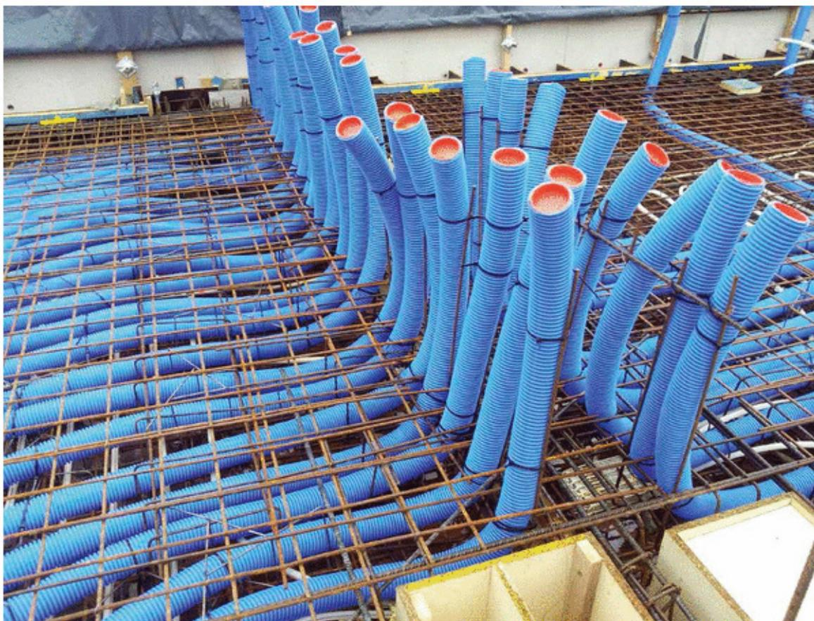
Umfangreich verlegte Lüftungsrohre können wie Schwimmkörper wirken und beim Betonieren die gesamte Bewehrung anheben.
